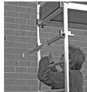
Alapállvány első és második magasítással
